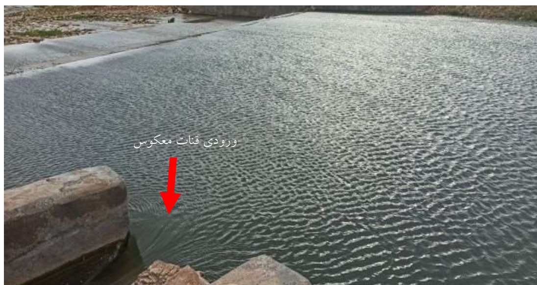
شکل ۶. سازه ذخیره و انتقال رواناب به داخل قنات معکوس
